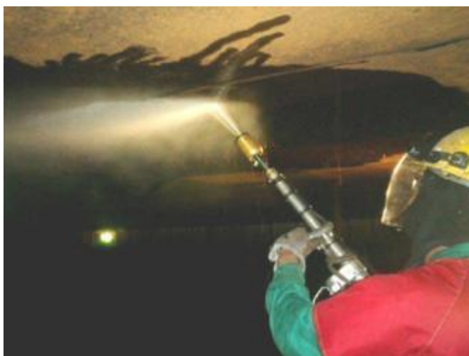
Ferramenta produzindo em teto de tanque.
